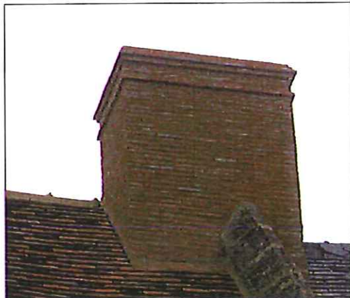
Souche de cheminée restaurée (Cour de Justice)
