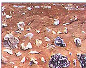
Enduit récent de bonne facture
