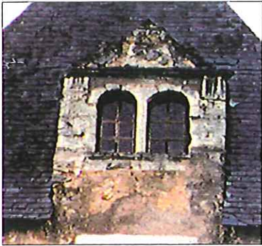
Lucarne à fenêtre géminée, sur le Pavillon, place Du Guesclin
