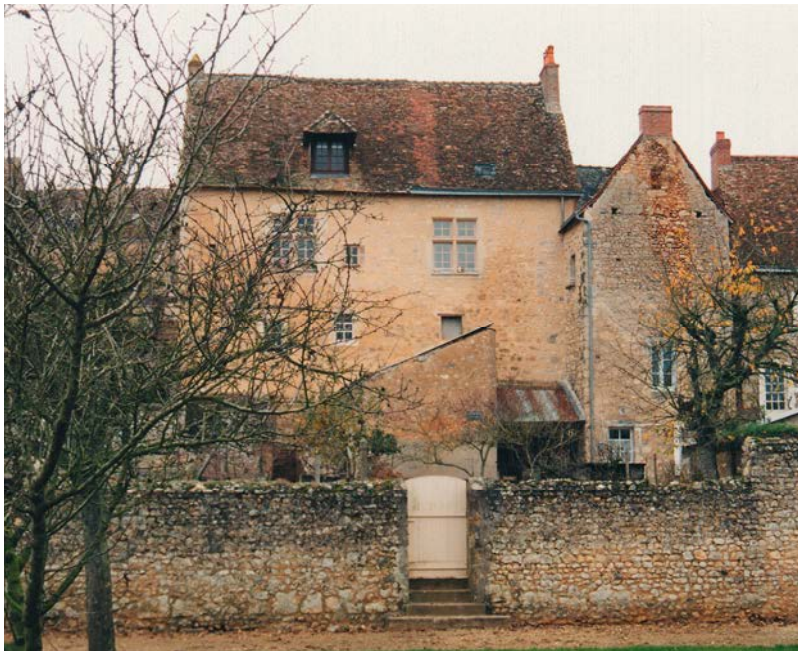
Maison datant du développement de PARCE au cours des XV ème et XVI ème siècles, en moellons enduit avec des croisées en pierres calcaires.
