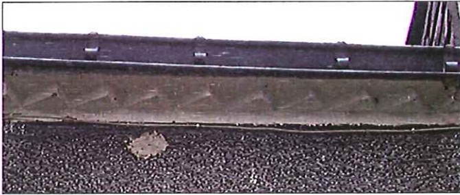
Type de corniche très répandu sur la commune, ici, rue Saint Hilaire et chemin de Trompe-Souris
