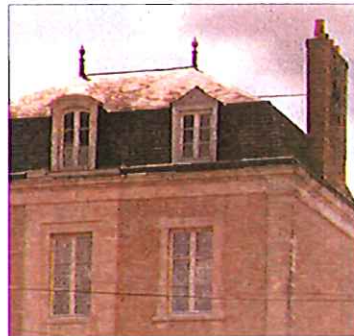
Toit dit "à la Mansart", route de Sablé-sur-Sarthe
