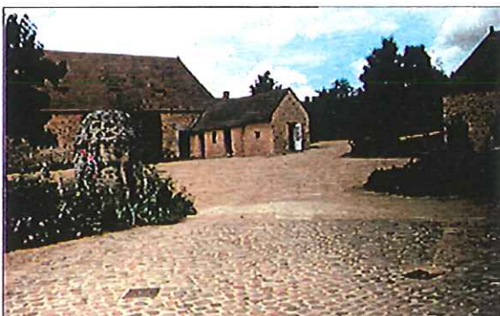
Le puits est la plupart du temps implanté au milieu de la cour formée par plusieurs corps de bâtiments agricoles (ici, la Basse-Cour)
