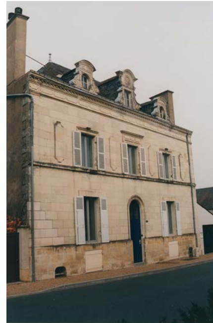
Maison XIX ème avec la façade principale entièrement en tuffeau, et la toiture en ardoises.
