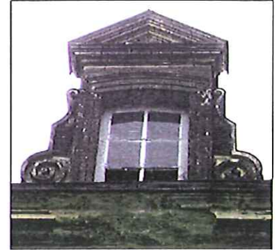
Lucarne en pierre ouvragée, rue du lavoir
