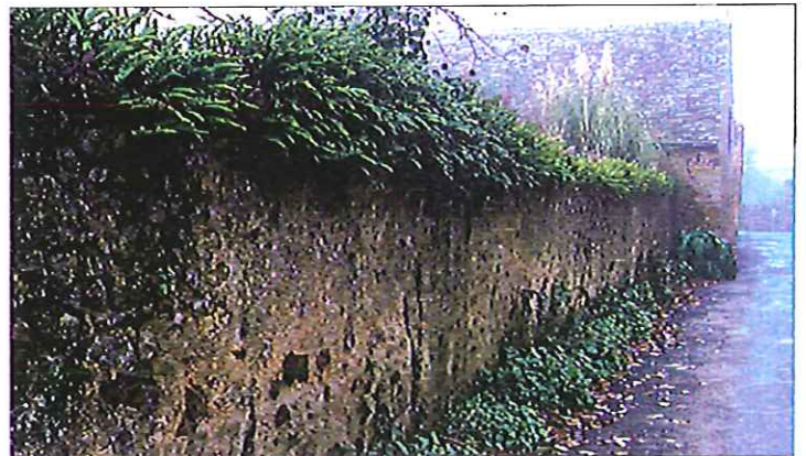
Mur ancien, avec de la végétation intersticielle au pied et à la tête du mur, rue des Arcis
