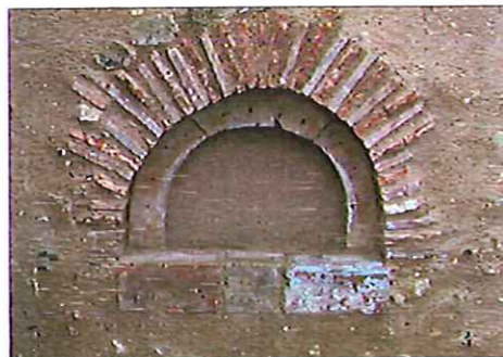
Fenêtre en demi-cercle, murée, avec un encadrement en briques, rue de la Grange
