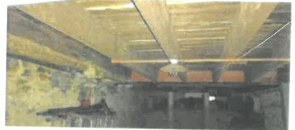
cave en sous-sol (hauteur sous plafond < à 1,80m)
