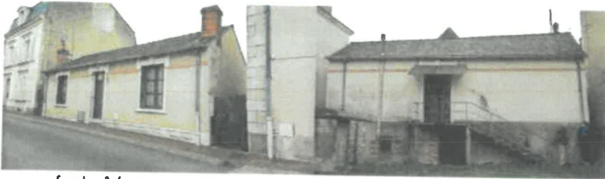
façade côté rue
